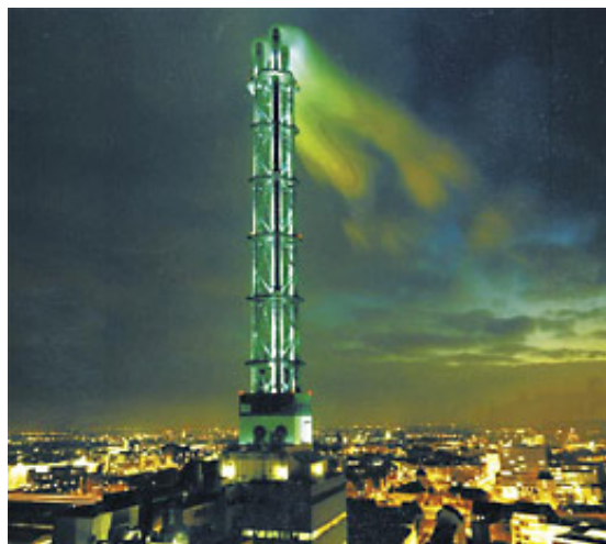
Rauchgaskamine der Heizkraftwerke in Duisburg: mit 185 Metern überragt der grün beleuchtete Stadtwerketurm die Mercatorstadt. Foto: DVV
